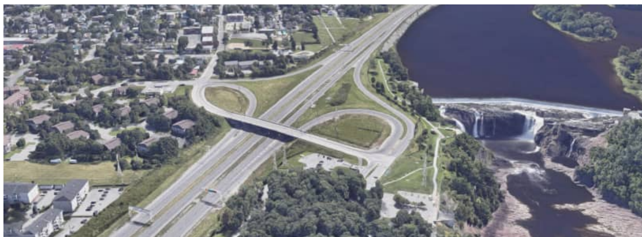
Figure 30 : Accès au Parc-des-Chutes-de-la-Chaudière
