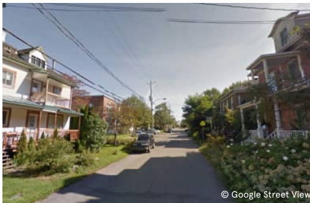
Figure 21 : Tissu résidentiel Le tissu résidentiel du Vieux-Charny est composé principalement de maisons isolées de 1 à 3 étages.
