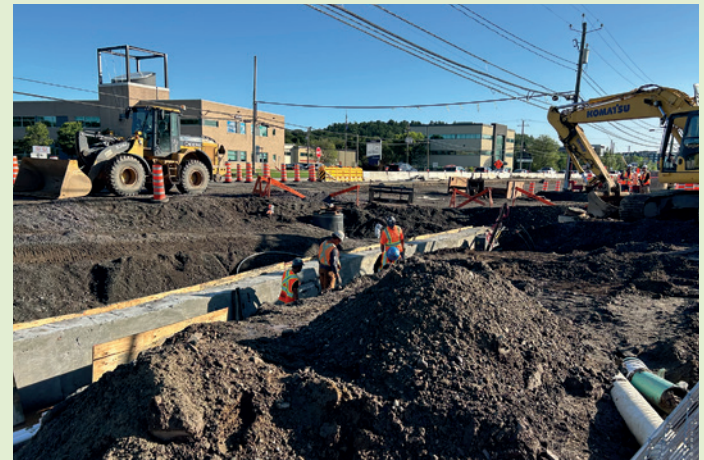
Travaux de construction des massifs souterrains d'utilité publique pour enfouir les fils électriques et les câbles de télécommunication dans la zone d'intervention du secteur Saint-Romuald.
