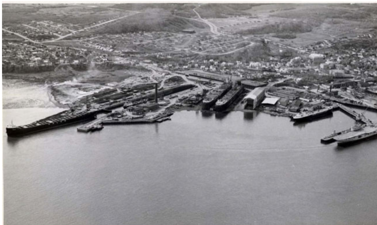
Figure 12 : Vue aérienne des chantiers maritimes en 1958. Source : BAnQ, cote P428, S3, SS1, D7, P14.
