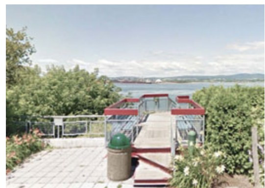
Figure 38 : Escalier — Rue Fagot
