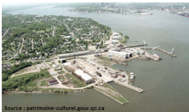
Figure 30 : Industrie — Chantier maritime
