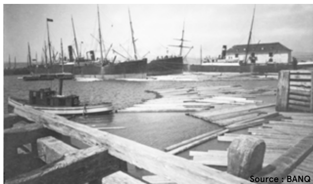
Figure 31 : Industrie — Chantier maritime — 1900
